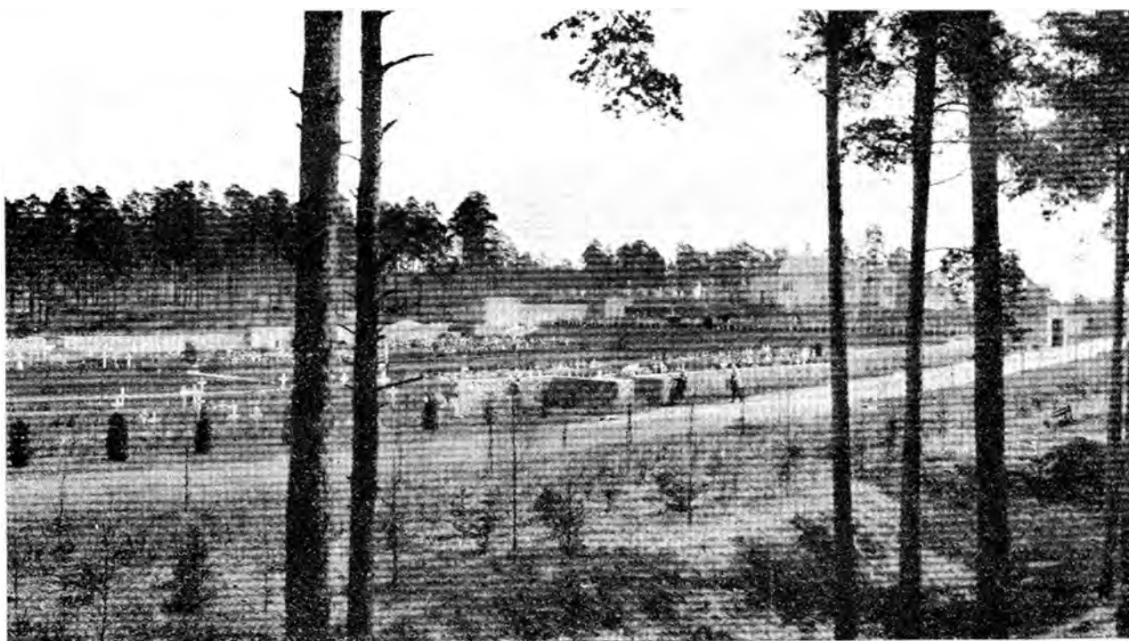
Skats no tas pašas vietas uz Braļu kapiem un daļu no apkārtnē valņa 1926. gada pavasarī
