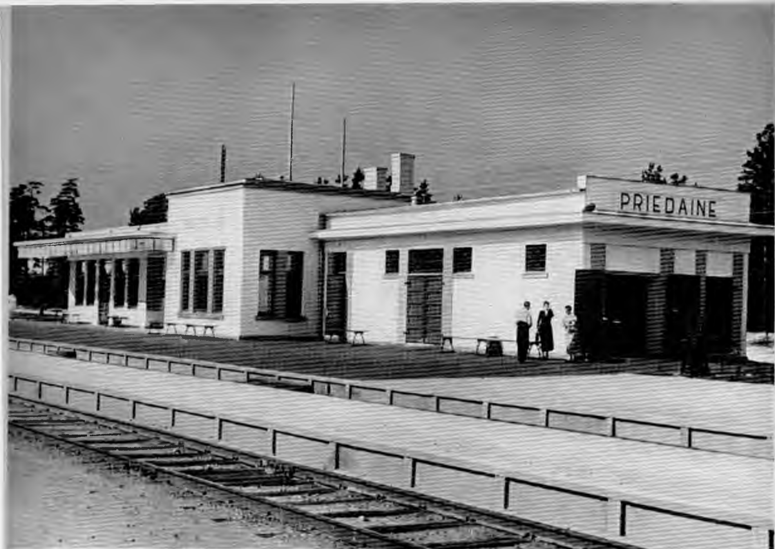
Priedaines jaunā dzelzceļa stacijas ēka.
